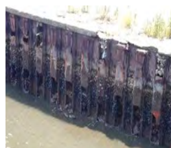
老朽化した護岸の例
