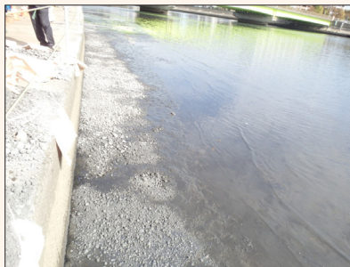
施工(Hiビーズ敷設)完了状況 (敷設幅2.5m)
