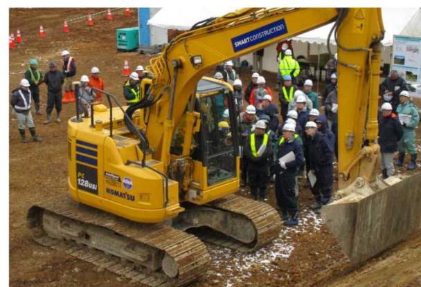
図-2.7 ICT 建設機械説明状況 2)
